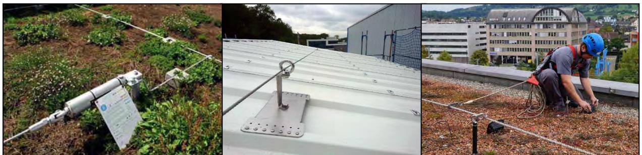
Eine eventuelle Einbindung in den Gebäudeblitzschutz ist nicht verpflichtend, muß aber vom Produkt her gesehen was die Leitfähigkeit betrifft möglich sein ( z.B. INNOTECH® ), wenn dies der Baubescheid, der E-Planer, der Bauherr oder die ÖBA vorgibt. Eine Stromentnahmemöglichkeit im Bereich Anlagen ist vorzusehen.
